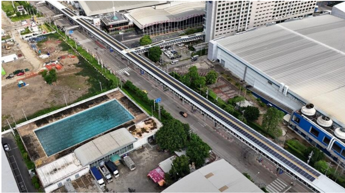
รูปที่ 15 โครงการย่อยที่ 15 บริษัท อิมแพ็ค เอ็กซิซิชั่น แมเนจเม้นท์ จำกัด (IMPACT SKYWALK NOVOTEL), 94 ถนนปิ่นเกล้า ตำบลบ้านใหม่ อำเภอปากเกร็ด นนทบุรี 11120
