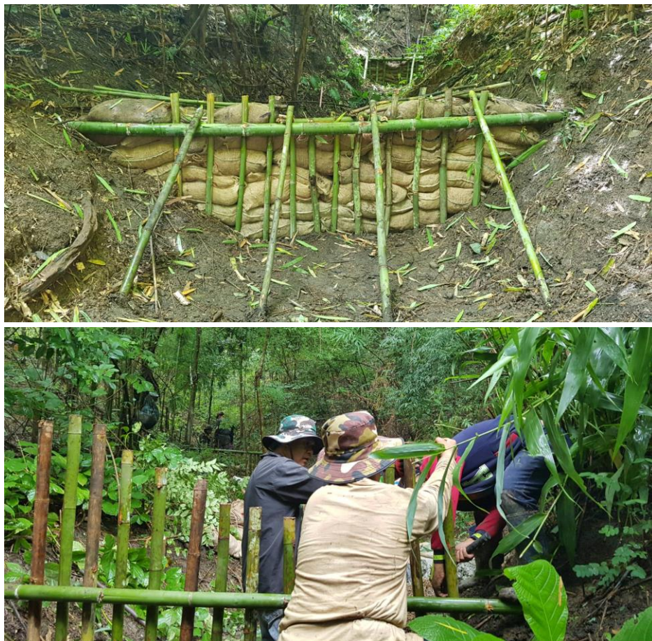
ภาพที่ 76 กิจกรรมสร้างฝายชะลอน้ำของชุมชนบ้านใหม่สามัคคี
