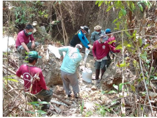
ภาพที่ 16 การสร้างฝายชะลอน้ำเพื่อเพิ่มความชุ่มชื้นให้กับผืนป่า
