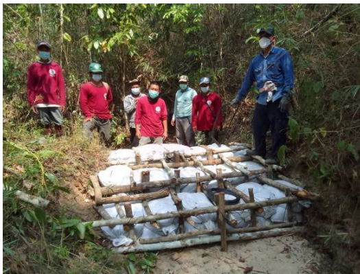
ภาพที่ 16 การสร้างฝายชะลอน้ำเพื่อเพิ่มความชุ่มชื้นให้กับผืนป่า
