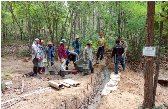
ภาพที่ 24 สร้างฝายชะลอน้ำเพื่อเพิ่มความชุ่มชื้นให้กับผืนป่า
