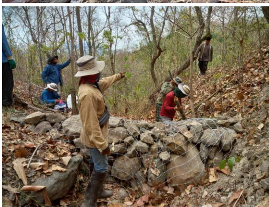
ภาพที่ 120 กิจกรรมสร้างฝายชะลอน้ำของชุมชนบ้านปี่ (หมู่ที่ 7)
