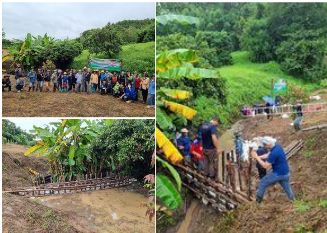
ภาพที่ 95 กิจกรรมสร้างฝายชะลอน้ำของชุมชนบ้านเวียงจอมจ้อ
