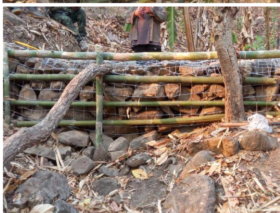
ภาพที่ 120 กิจกรรมสร้างฝายชะลอน้ำของชุมชนบ้านปี่ (หมู่ที่ 7)
