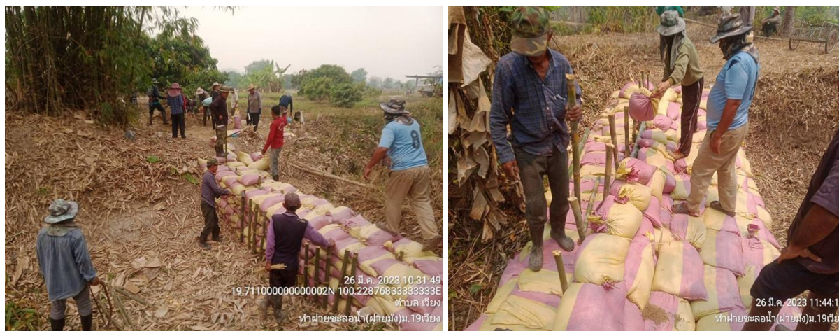
ภาพที่ 84 กิจกรรมสร้างฝายชะลอน้ำของชุมชนบ้านทุ่งเฉลิมพระเกียรติ
