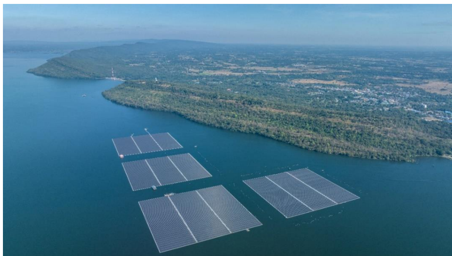
รูปที่ 1 โครงการโรงไฟฟ้าพลังงานแสงอาทิตย์ทุ่นลอยน้ำร่วมกับโรงไฟฟ้าพลังน้ำเขื่อนอุบลรัตน์ ชุดที่ 1
