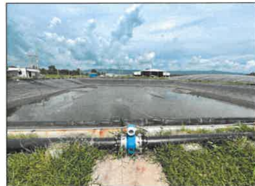
แนวท่อลำเลียงก๊าซชีวภาพจากระบบ Modified Cover Lagoon (MCL) ไปยังระบบ H 2 S Bio-Scrubber
