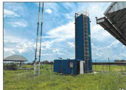
ระบบปรับปรุงคุณภาพก๊าซชีวภาพ (H 2 S Bio-Scrubber)
