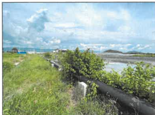
แนวท่อลำเลียงก๊าซชีวภาพจากระบบ Modified Cover Lagoon (MCL) ไปยังระบบ H 2 S Bio-Scrubber
