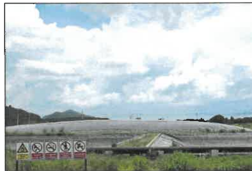
ระบบบำบัดน้ำเสียแบบ Modified Covered Lagoon (MCL)
