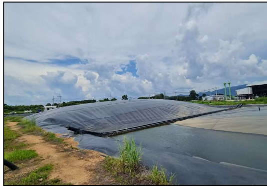
รูปที่ 1-5 ระบบบ่อหมักแบบไร้อากาศแบบ Modified Covered Lagoon (MCL)
